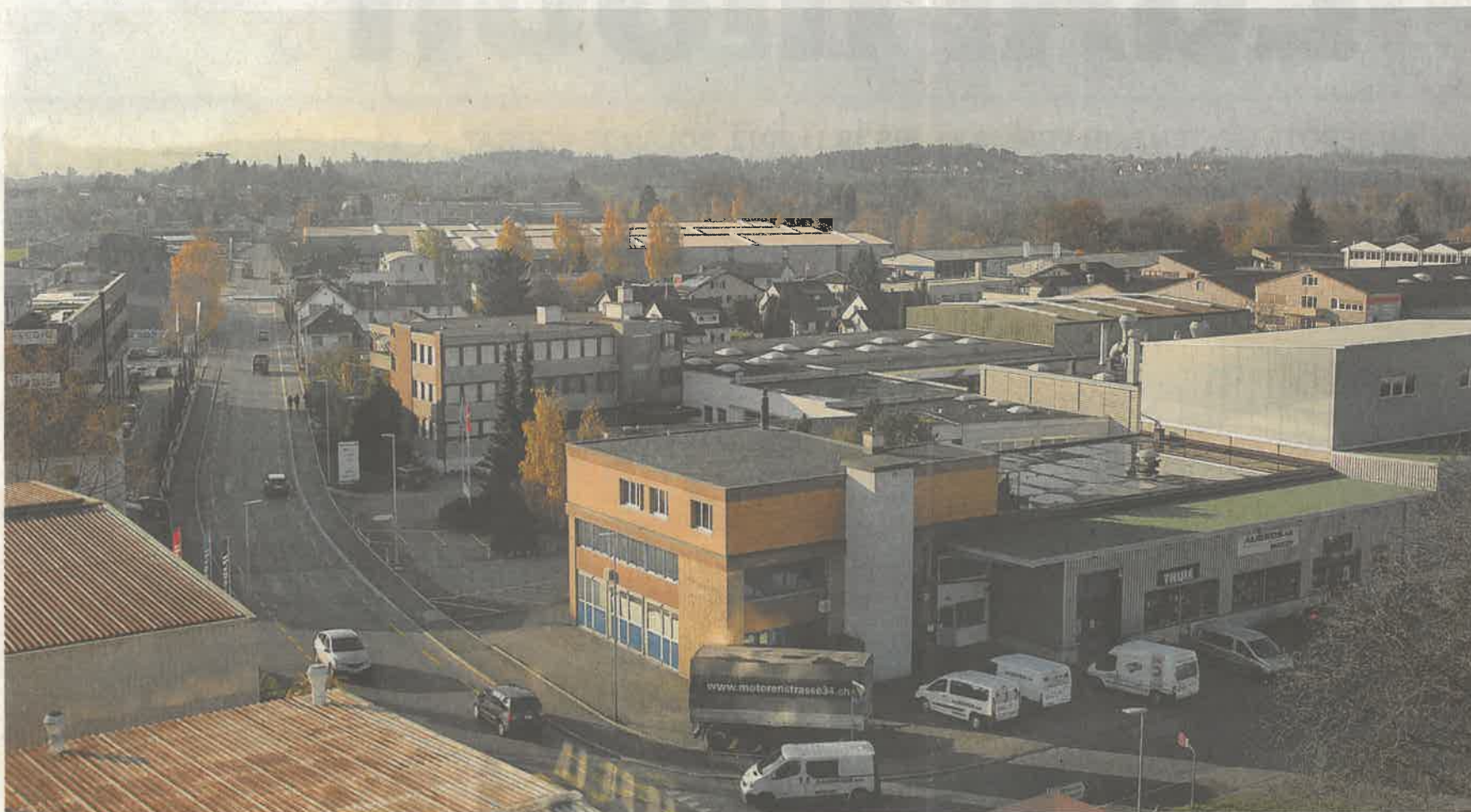
Das Wetziker Industriequartier bleibt unverändert: Das Ansinnen des Gemeinderats, den Wohnanteil zu erhöhen, wurde abgelehnt. Bild: Mirjam Müller
